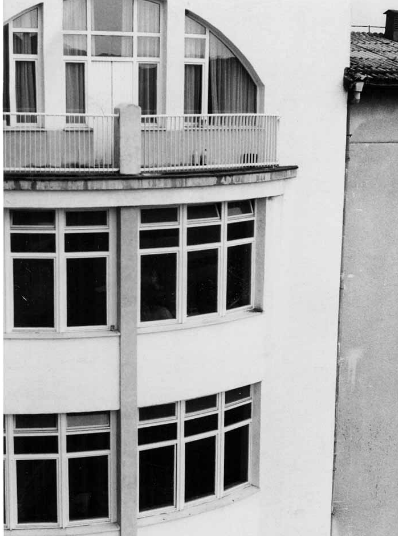
Medzidek med staro zgradbo in prizidkom
